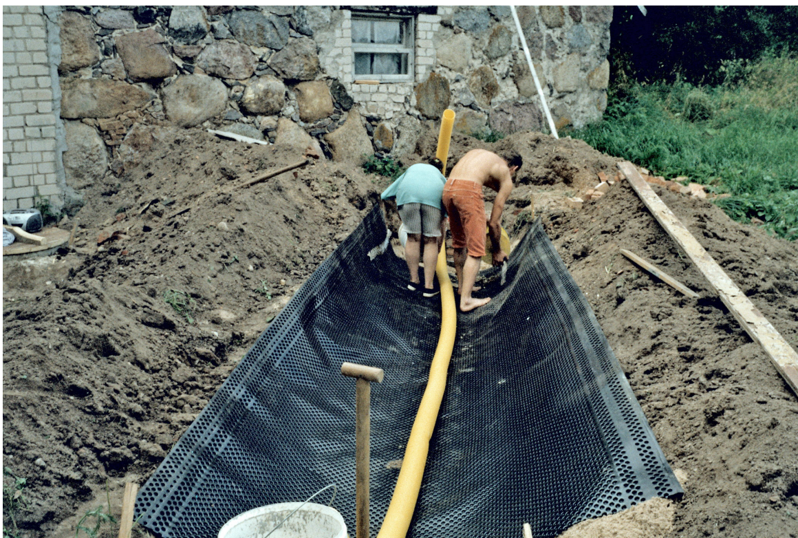
Der graves afløb til multitoiletet.
