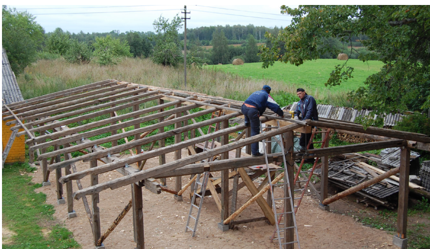
Brændeskuret rives ned og et nyt bygges af de gamle bjælker. Taget var beklædt med træspån.
