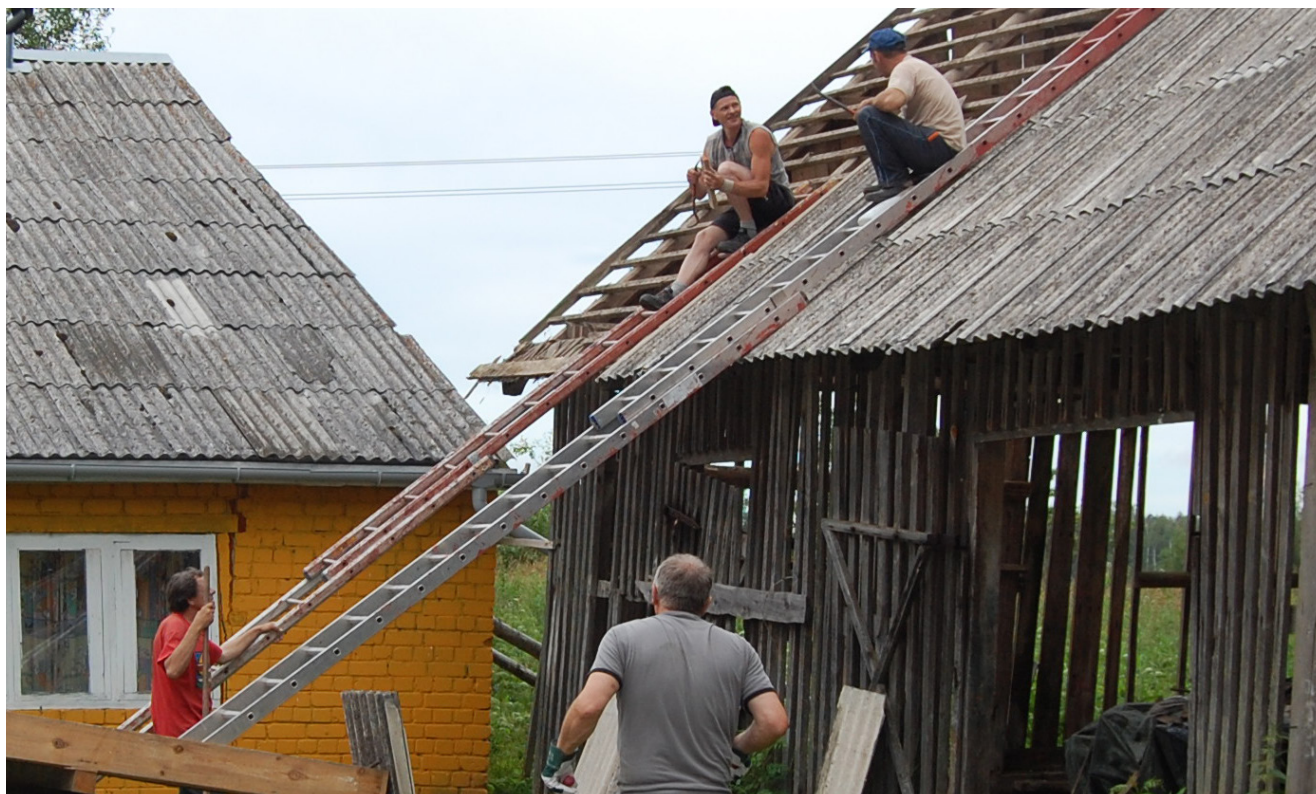
Brændeskuret rives ned og et nyt bygges af de gamle bjælker. Taget var beklædt med træspån.
